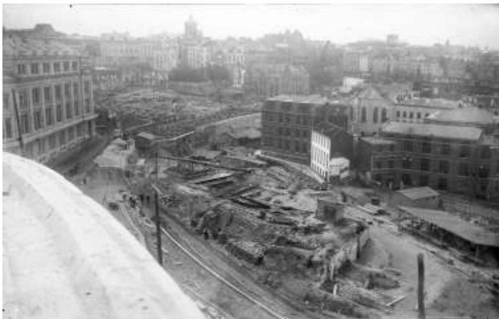
Illu. 36 : Vue sur la future rue Ravenstein depuis l'immeuble de la Caisse Générale de Reports et de Dépôts (c. 1911). Le pensionnat Héger-Parent et le Passage de la Bibliothèque ont disparu, mais la Société Générale n'a pas encore agrandi ses bureaux. Au centre, l'îlot en démolition accueillera le square et la sculpture La Maturité .
