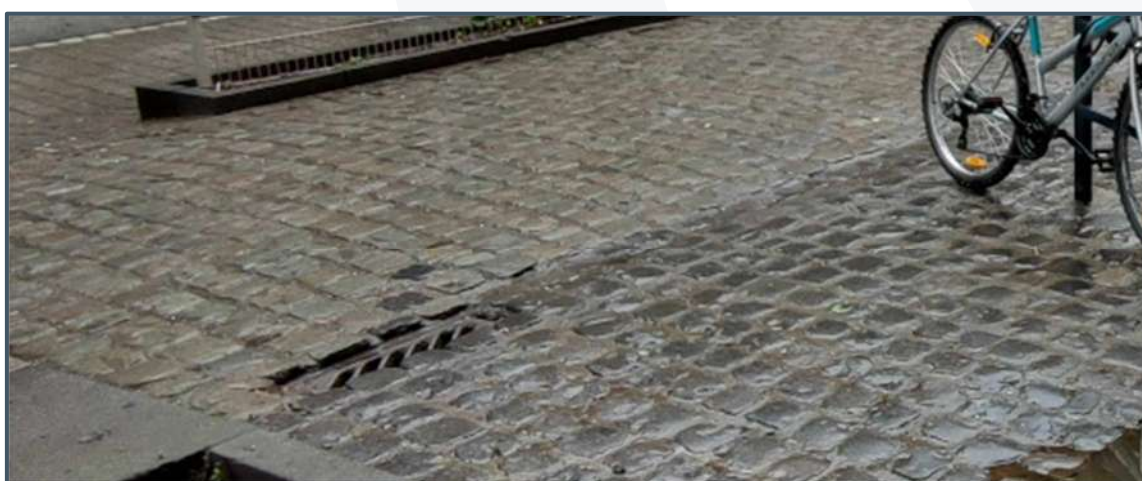
Le revêtement du plateau et des zones de stationnement
