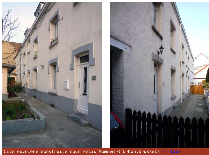
Cité ouvrière construite pour Félix Mommen © Urban.brussels -> Lien
