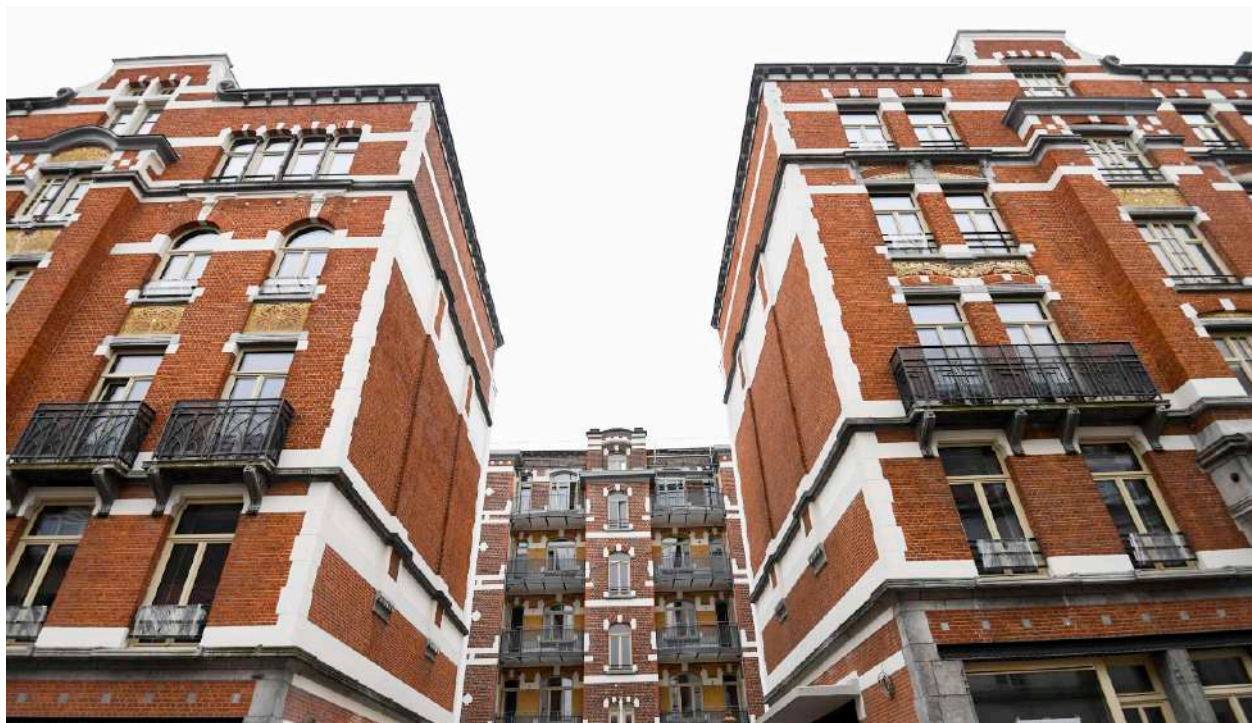
La cité L'Olivier après rénovation © Beliris -> lien
