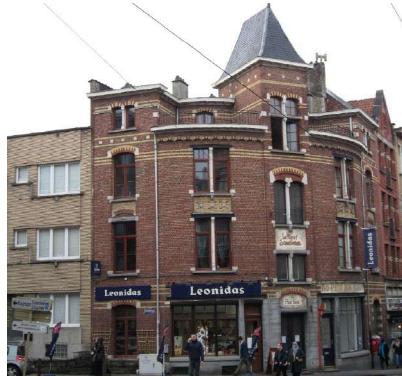
Coin de la chaussée de Helmet et de la rue du Foyer Schaerbeekois, arch. Henri Jacobs © Urban.brussels -&gt; lien
