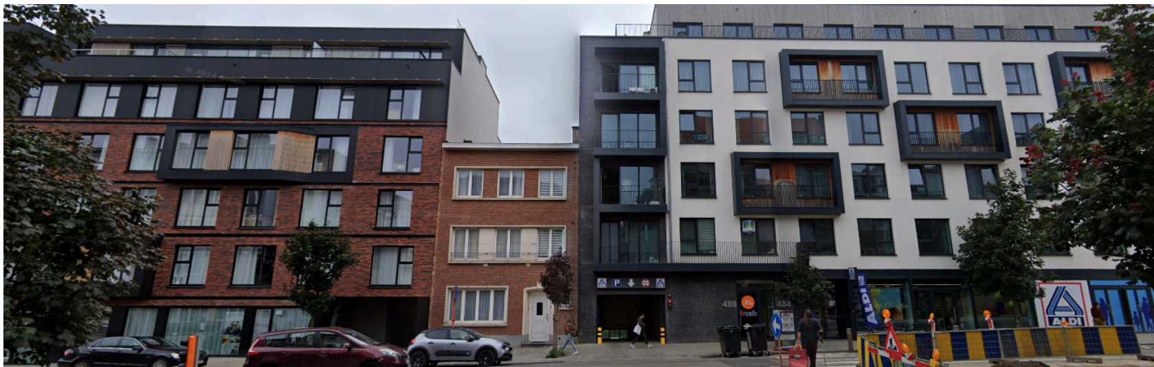
Avenue de la Couronne : projets Bouygues (à gauche) et Aldi (à droite). Source © Google StreetView
