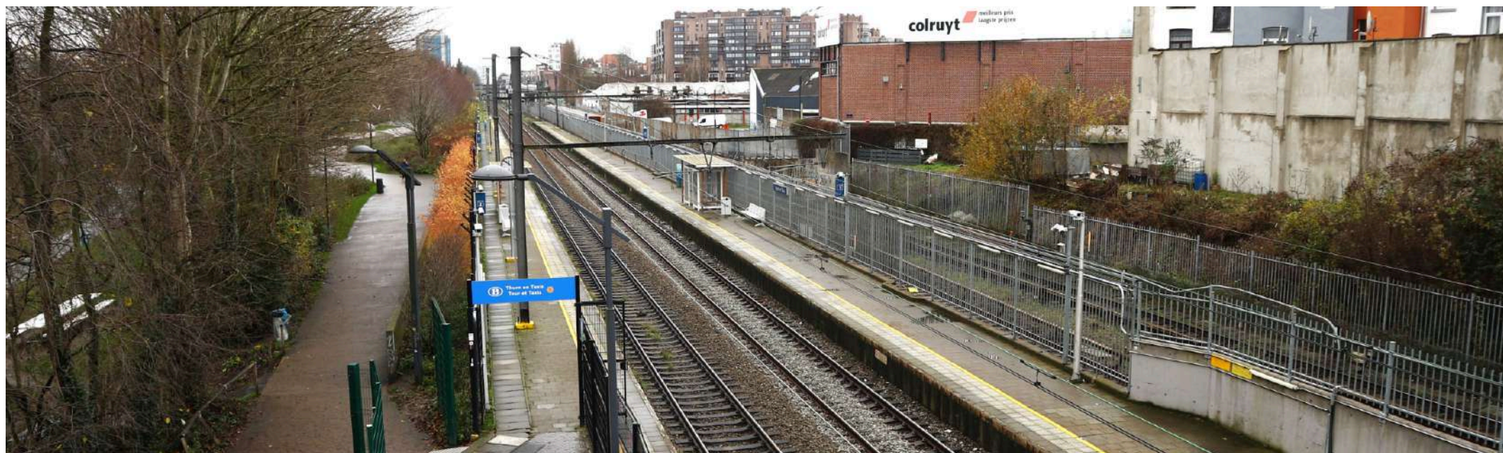
La gare de Tour et Taxis. Source © ARAU
