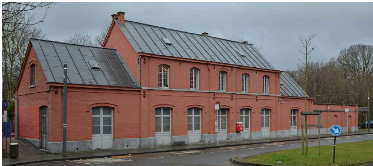
La gare d'Uccle-Stalle. Source : Inventaire du Patrimoine architectural de la Région de Bruxelles-Capitale (-> lien )
