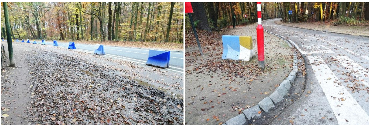
Etat des trottoirs (à gauche) et hauteur des bordures au débouché d'un passage piéton (à droite) (photos novembre 2021 ©ARAU).
