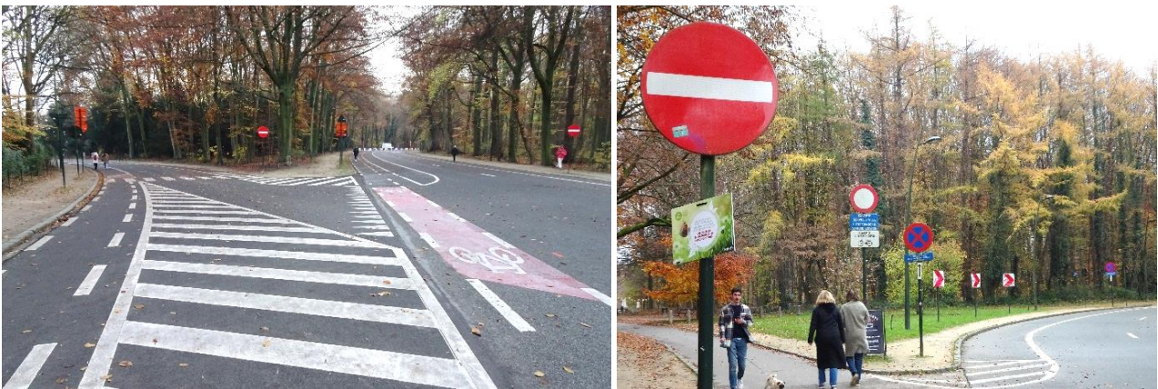
Abondance de marquage au sol, grand nombre de panneaux de signalisation... le bois de La Cambre doit se défaire de son aspect autoroutier pour être réapproprié par la population (photos novembre 2021 ©ARAU).
