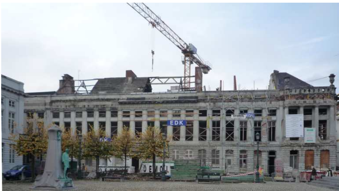
Le chantier en novembre 2008 © reflexcity.net
